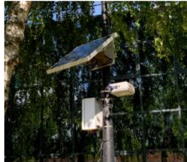
Installation panneau solaire 55W sur mât
