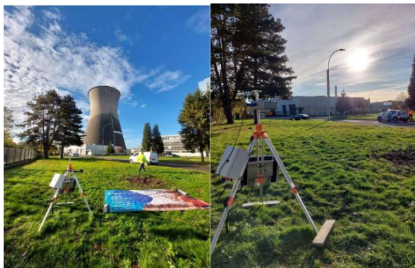
Figure 1: installation de suivi des poussières fines au dynamitage de la TAR (tour aéroréfrigérante) — sur site
