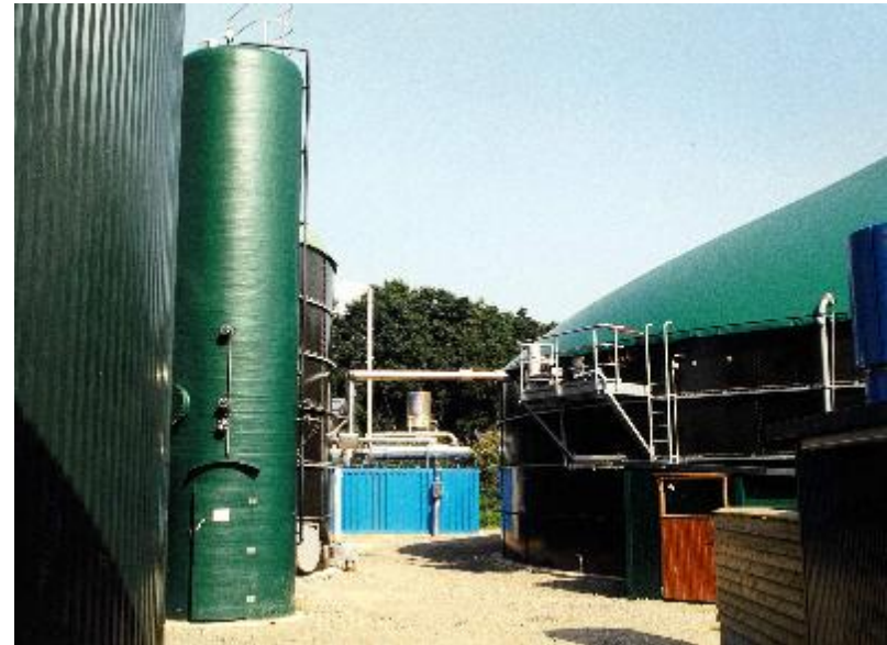
Tour de désulfuration biologique de biogaz
