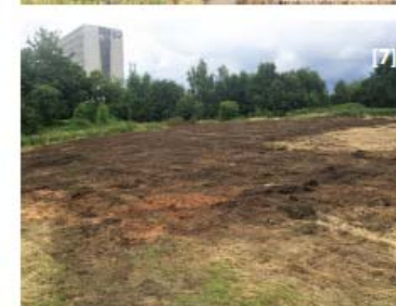
Enfouissement de terres contaminées par des rhizomes de renouées asiatiques dans une cellule de confinement
